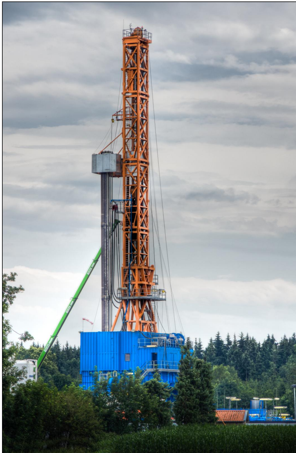
Foto: DS 10 Bentec 350-t-AC Euro Rig™ auf dem Bohrplatz in Taufkirchen
